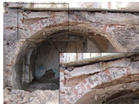
Рис. 2. Сводчатое перекрытие здания по улице Мусы Джалиля 16, г. Казань Figure 2. Masonry vault 16 Musa Djalil str., Kazan
