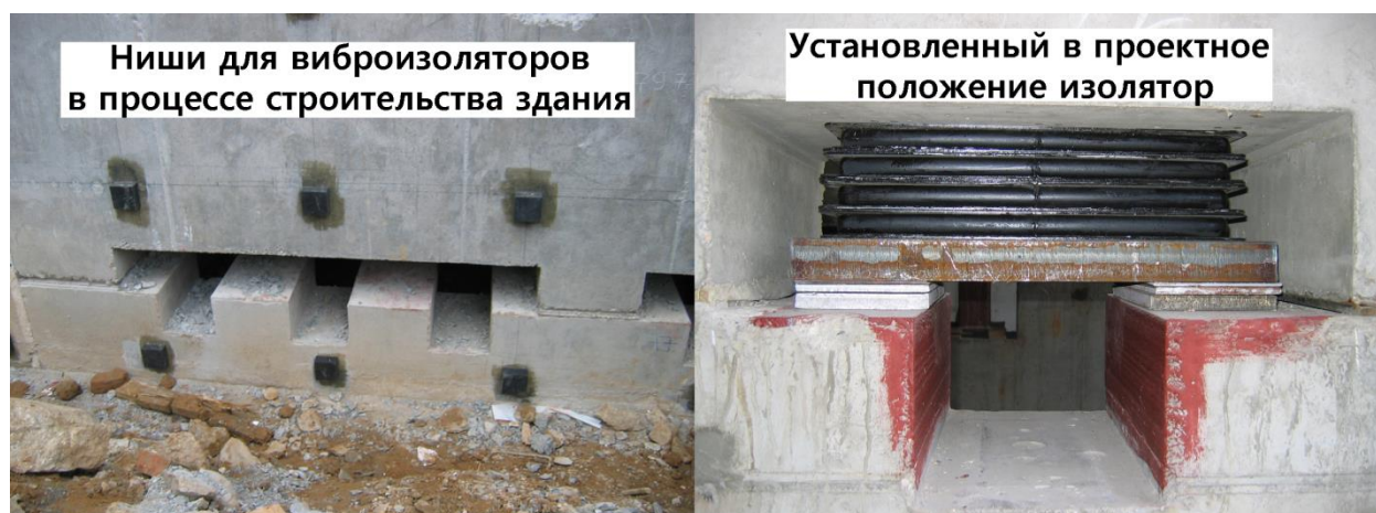
Рис. 2. Конструкции ниш для установки виброизоляторов после бетонирования цокольного этажа здания и ниша с установленным в проектное положение виброизолятором
