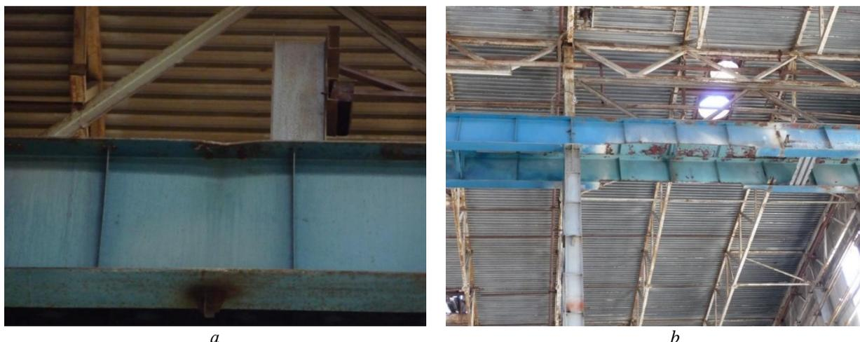
**Рис. 2.** Механические (а) и коррозионные (b) повреждения подкрановых балок
