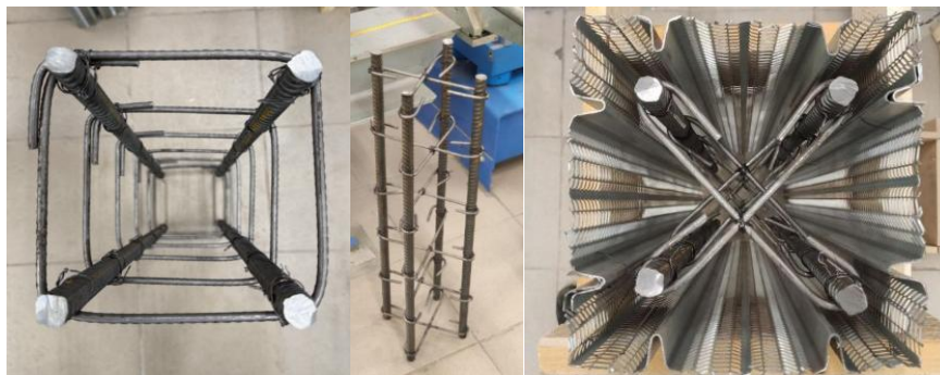
Рис. 3. Сборка арматурного каркаса Fig. 3. Manufacturing of reinforcement cage
