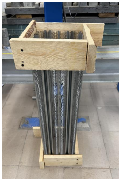
Рис. 2. Изготовление опалубки Proster®21 требуемых размеров Fig. 2. Manufacturing of Proster®21 formwork of the required dimensions
