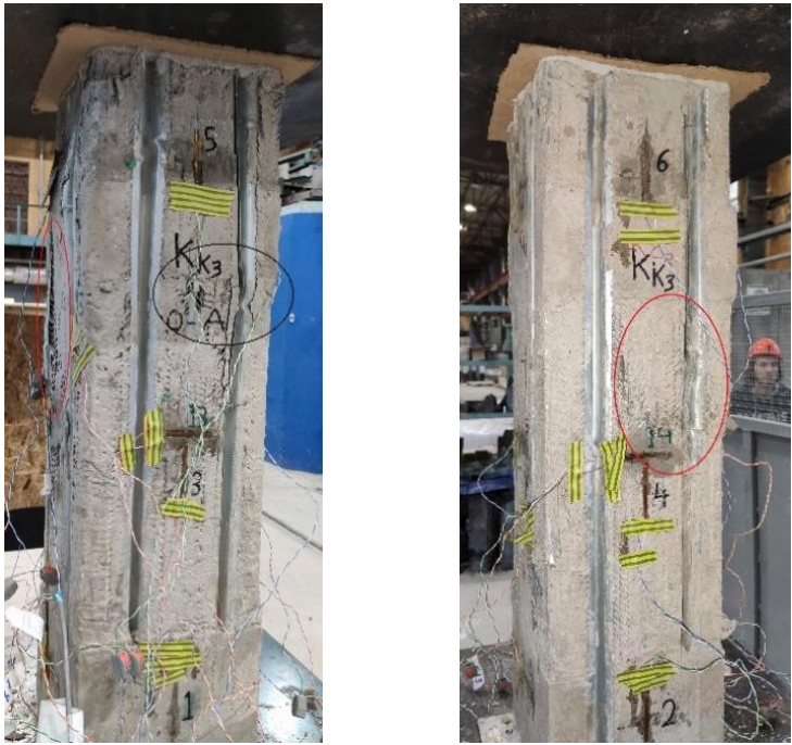
Рис. 6. Механизм разрушения колонны KK3 Fig. 6. Crack patterns and failure of the column KK3
